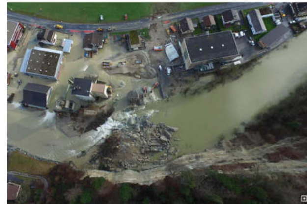
Der Felssturz blockiert die Kleine Emme in Wolhusen. Das nahestehende Industrieareal wird überschwemmt. (ZSO Emme (Archiv))
