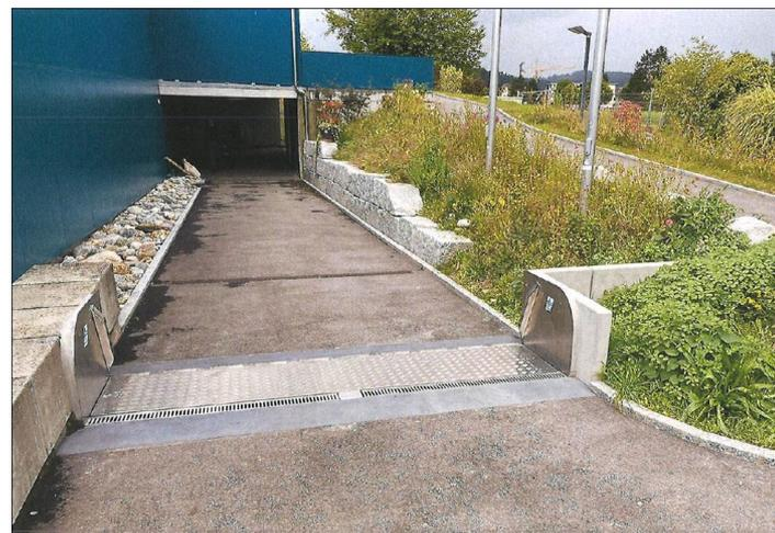
Umgesetzte Massnahme: Automatisches Klappschott, Betonelemente, Blocksteine und Dammbalkensystem (Seitenzugang)
